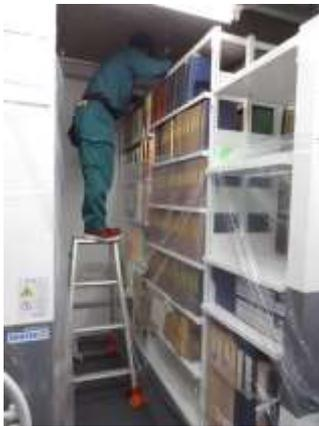
次いで書架や周辺の床が汚れないように養生を行う。水を使って高所での洗浄作業とあって、下の書架の資料への影響が気になるが、普段は食品工場の空調機を扱うことも多いというファインテック社、水漏れ対策は万全である。左右両方の書架を大型のビニールシートで厳重に覆い、エアコン自体も全体を覆い、その覆ったシートの中に手を差し入れて作業を進める。またエアコンを覆ったシートから別のビニールシートを筒状にして下へ垂らし、臨時の排水ホースにする。書架の資料を移動させる必要は全く無かった。
