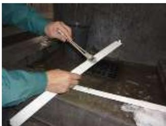
仕上げに、各部品に真菌を寄せ付けない水性防カビコーティング剤を刷毛で隅々まで塗布していく。この水性防カビ剤でコーティングしておくこと、カビの孢子が生えず、飛んできて根付くこともない。作業のポイントは、刷毛で叩くように塗ってゆくこと。高圧洗浄でも洗い落とせなかったカビもこれで完全に滅菌される。また、コーティングの出来ない熱交換器やフィルターには、抗菌・防カビ・消臭を同時に行うスプレー「エアーファイン」を噴霧して、防カビの被膜を作る。
